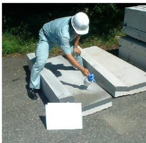
（2次製品施工状況）
