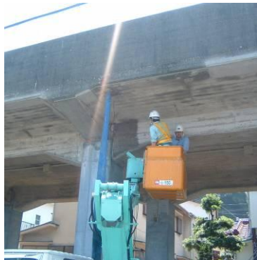
（梁及び床版下部施工状況）
