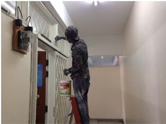
「アンチモスキュー」を塗装中
